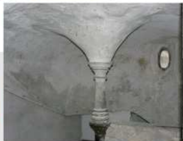
Quelques cages d'escalier ont gardé leur couverture originel, portée par une colonnette, située en prolongement du noyau de la vis.
