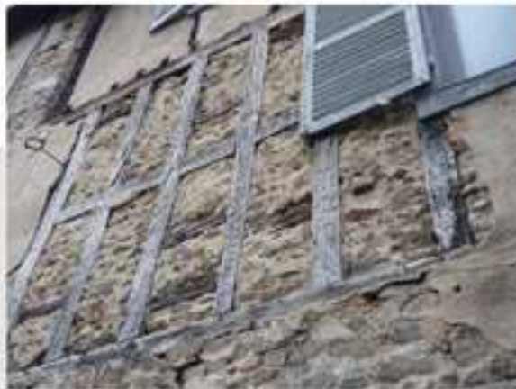
Les poutres sablières structurent horizontalement aux 15 e et 16 e siècles les niveaux de la façade qu'elles animent par un jeu de moulures
