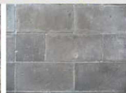
Pierres de taille assisées à joints vifs
