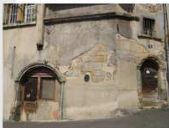
Façade arrière de la maison 8, rue de Grenette (16e siècle) : la maçonnerie est composée de blocs de grès destinés à être vus
