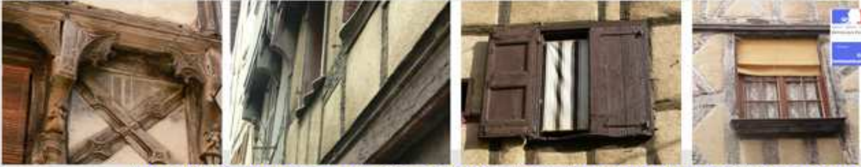
Le pan de bois forme des panneaux dans lesquels s'inscrivent les ouvertures, en tenant compte de la trame porteuse
