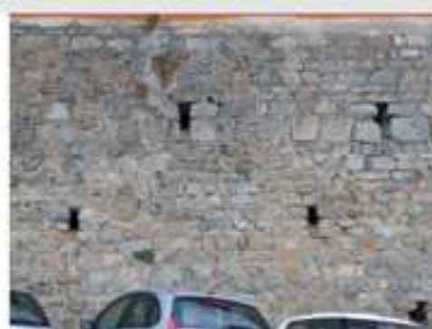
Moellons assisés à joints beurrés
