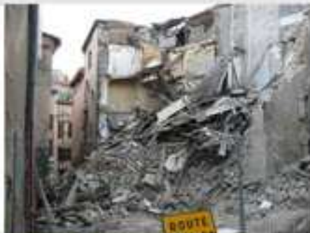
Les immeubles s'épaulent entre eux....
