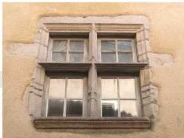
Façade arrière de la maison 8, rue de Grenette (16e siècle) : la maçonnerie est composée de blocs de grès destinés à être vus
