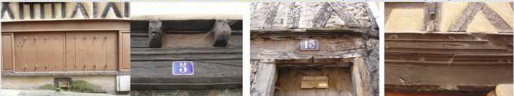
Les poutres sablières structurent horizontalement aux 15 e et 16 e siècles les niveaux de la façade qu'elles animent par un jeu de moulures
