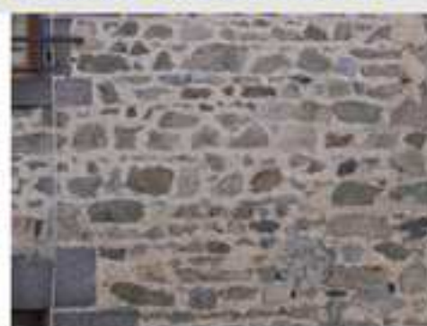
Moellons irréguliers destinés à être enduits
