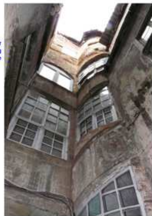
Escalier en vis logé dans une tour semi hors œuvre, rue du Bourg (milieu du 16 e siècle). Une coupole en tore couronne la vis.
