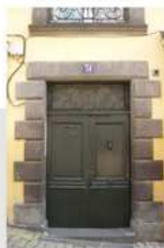
Porte au 31, rue Conchette (seconde moitié 17e siècle) : les pierres en bossages sont taillées dans la pierre de Volvic.
