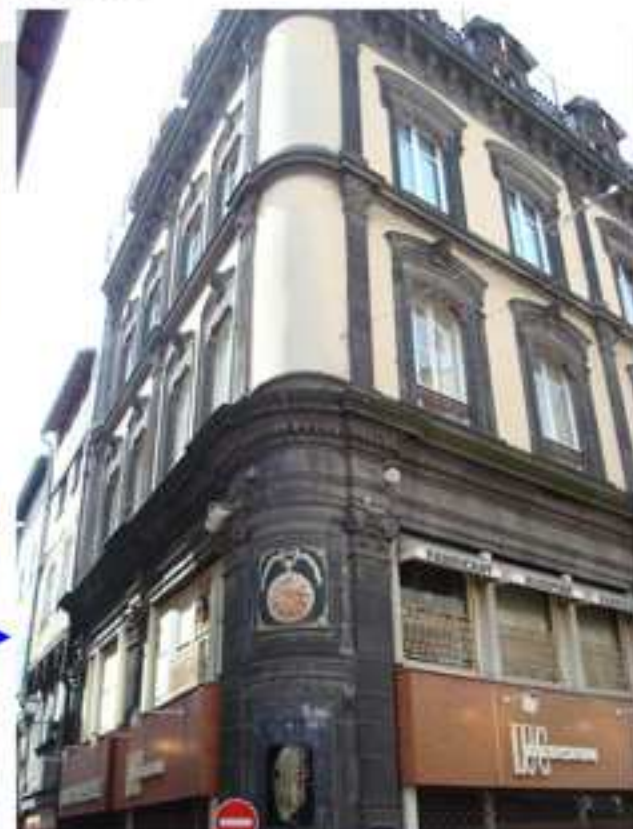
L'emploi de la pierre de Volvic s'entend jusqu'au 19e siècle : l'immeuble au 2, rue Terrasse, avec son riche décor classique, en est une représentation remarquable
