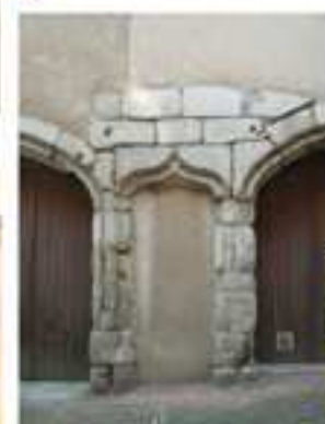
Maison 1, rue Gambetta (seconde moitié 15e siècle) : porte, arcades de boutiques et mur construit en granite. La régularité des blocs de pierre atteste la volonté de laisser voir la maçonnerie de la façade
