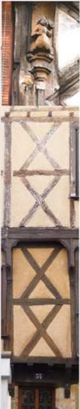
Les poutres sablières structurent horizontalement aux 15 e et 16 e siècles les niveaux de la façade qu'elles animent par un jeu de moulures
