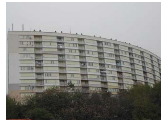
> Bâtiment des Jaiffours
