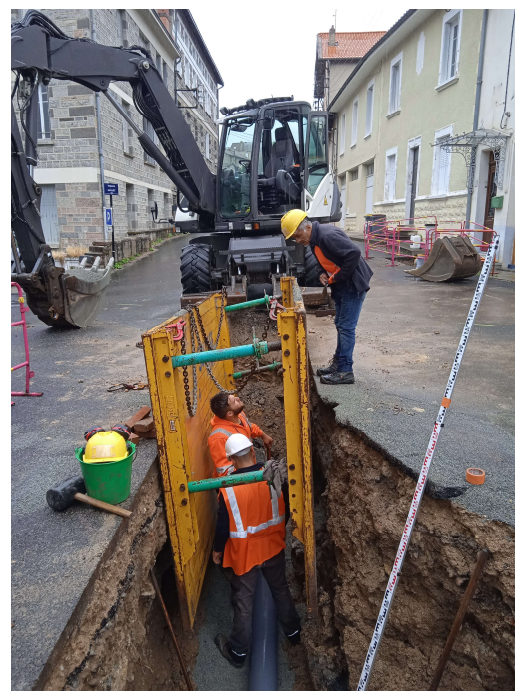
Assainissement : création réseau Impasse Mallet
