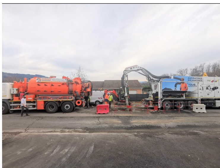
Eau potable : Réparation d'une fuite par les agents de la Régie
