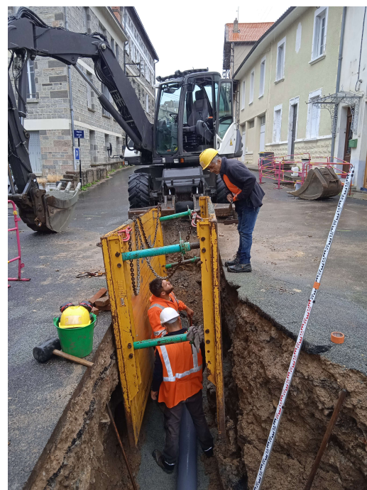
Assainissement : création réseau Impasse Mallet
