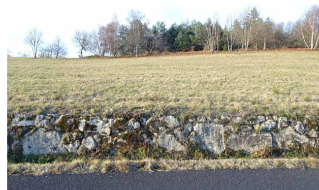
Soutènement d'un rebord de fossé en pierres de granite
