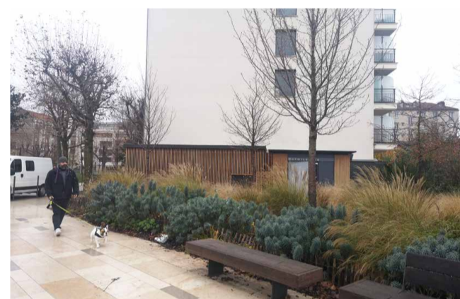
Intégration d'un poste de transformation en coeur urbain, adossé à un pignon d'immeuble. Habillage en lattes de bois verticales, ouvertures, couverture en bas acier sombre. Toilettes publiques attenantes du même habillage. Montrouge (92).
