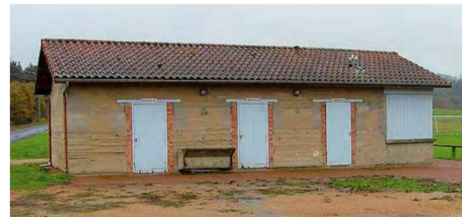
Restauration d'une maison en pisé
