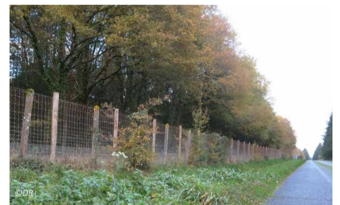
Double clôture en piquet châtaignier et grillage (deux rangs) - hauteur 2m.
