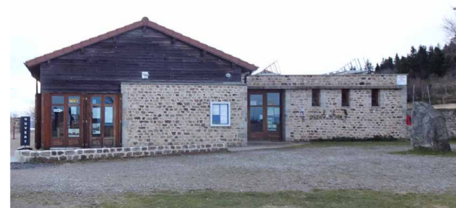
Pierres en granite, bois, tuiles en terre cuite et panneaux photovoltaïques à l'arrière du bâti principal et des vues, Col du Béal.
