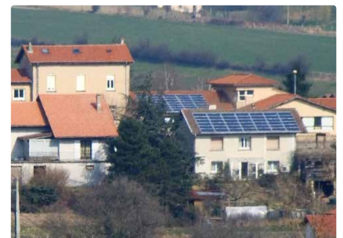
Toitures solaires individuelles, couvrant le maximum de toiture et similaires sur deux pans de toitures. Les Haies, Rhône.
