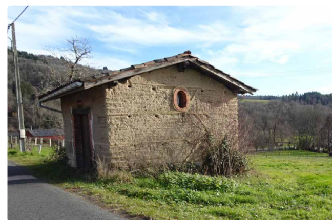
Edicule en pisé, bois et briques, Aubusson-d'Auvergne
