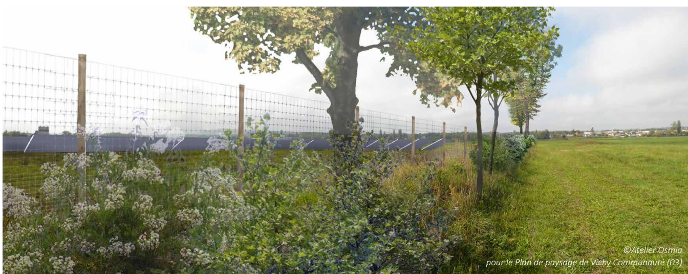
Ci-contre, simulation d'une clôture en piquets de châtaigniers et grillage (type ursus lourd), située à l'arrière de plantations d'essences locales, implantées de façon discontinue (non répétitive et non homogène), à 3 strates (arborée, arbustive, enherbée). Les plantations sont dans le périmètre de la parcelle à clôturer. Hauteur de clôture de 2m.
