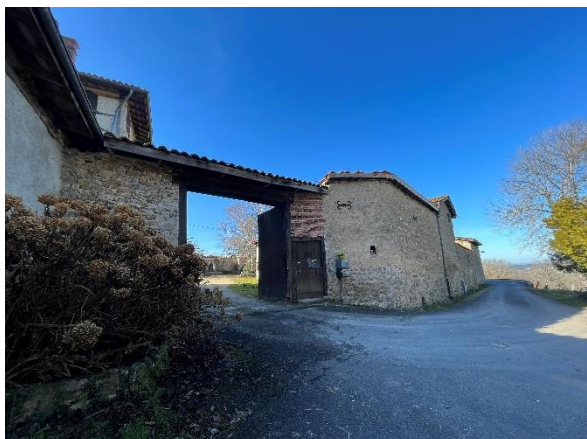
Entrée principale du Domaine Accès privé à la partie habitation
