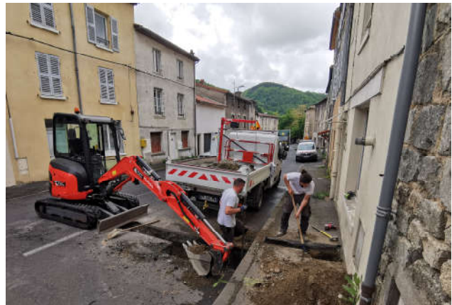
Assainissement : travaux d'urgence sur branchement par les agents de la Régie des Eaux
