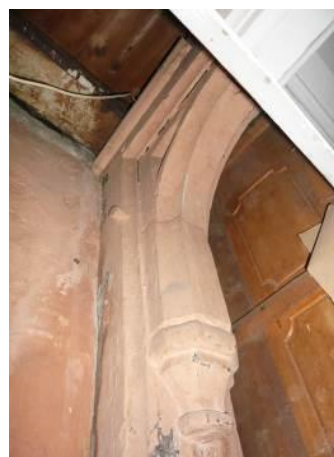
45, rue de la Coutellerie. Console ornée d'un écoinçon et d'un culot prismatique.
