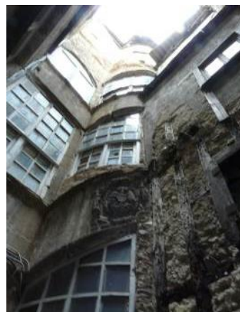
4, rue du Bourg. Escalier en vis demi-hors-œuvre sur cour
