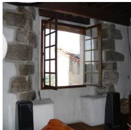
39 bis, rue de la Coutellerie. Coussièges en pierre aménagés dans l'embrasure de la fenêtre à meneau (division détruite).
