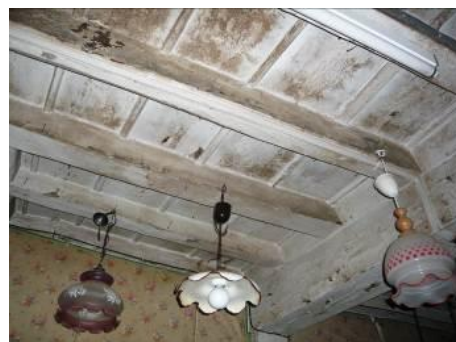
15, rue Conchette Plafond à la française conservant les closoirs et les couvre-joints.
