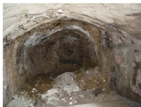
40, rue de la Coutellerie. Cave semi-enterrée taillée dans le substrat rocheux. Au fond, niche aménagée dans le rocher.
