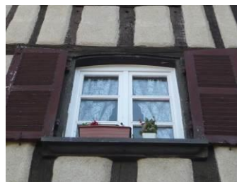
5, rue Rouget de L'Isle (253-60). Exemple de fenêtre à linteau segmentaire aménagée au XVIIIe siècle dans une façade en pan de bois du XVIIe siècle.
