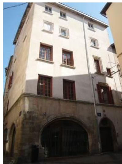
21, rue Alexandre Bigay. Le rez-de-chaussée en bel appareil de blocs d'arkose.
