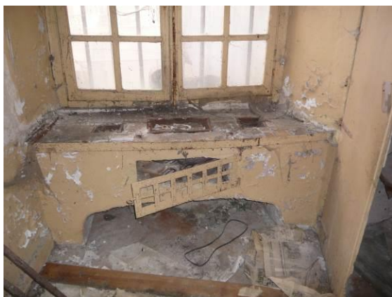
14, rue du Bourg (257-3). Potager implanté dans l'embrasure de la fenêtre du XVIIe siècle.
