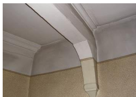
2, rue Alexandre Dumas. Dans un coffrage en lattis plâtré, la poutre maîtresse d'un plafond à la française supportée par des consoles en bois ouvragées.
