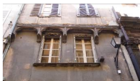
3, rue du Bourg. Une fenêtre à traverse (à gauche) et une fenêtre à meneau (à droite) constituent peut-être le binôme initial.
