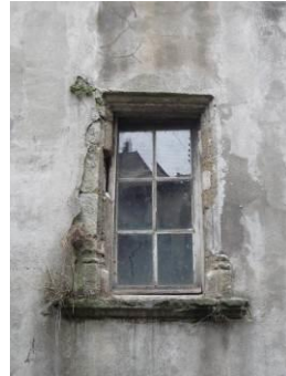
Rue Montmillant (62-72). Fenêtre à traverse éclairant la cage de l'escalier en vis.
