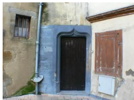
2, rue Alexandre Dumas. Linteau délardé d'un arc en accolade
