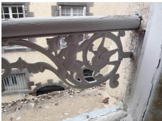
4, rue du Palais (456-9). Garde-corps de fenêtre en fonte moulée.
