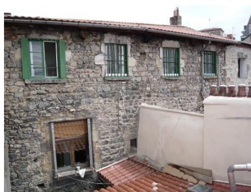
L'enceinte du castrum conservée en élévation sur laquelle s'appuie la demeure 18, rue du Palais. Le dernier niveau appartient à une phase de surélévation.
