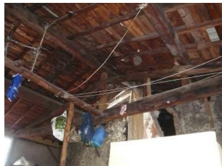
66, rue Gambetta. Charpente à ferme : arbalétriers, entrails et poinçons.
