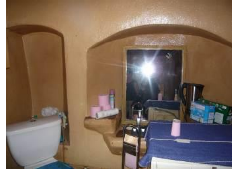
29, rue Durolle. La niche d'évier disposée au côté de la niche de latrines.
