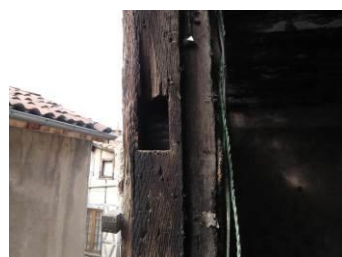
1, impasse de la Coutellerie Mortaise recevant à l'origine le tenon du croisillon de bois.
