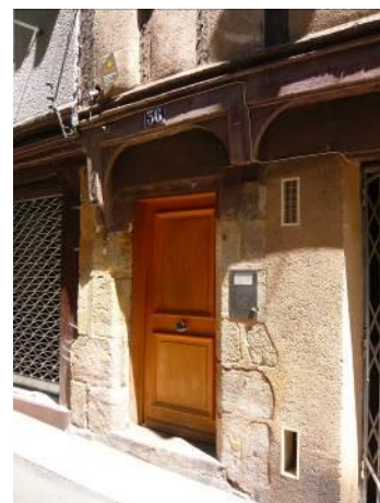
36, rue de la Coutellerie. Rare exemple de porte et de devanture inscrites sous des pigeâtres supportant la sablière de l'encorbellement du pan de bois du premier étage.
