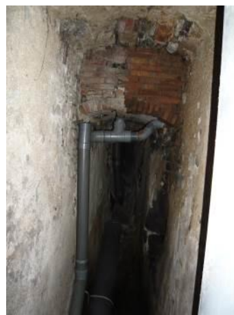
7, rue de la Coutellerie. Androne en rez-de-chaussée recevant les eaux des latrines pour les évacuer vers une venelle latrinale.
