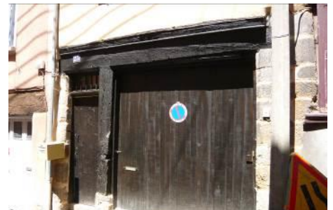
23, rue Gambetta. Devanture sous sablière chanfreinée, encadrée par un pilier maçonné et un poteau de bois dans lequel se situe la mortaise orpheline de l'égal en bois.
