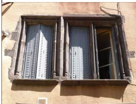
16, rue de la Coutellerie. Hormis les éléments de division disparus, le couple fenêtre à traverse-fenêtre à meneau s'impose sur cette façade maçonnée.
