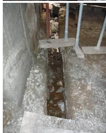
52, rue de la Coutellerie. Latrine logée dans l'épaisseur du mur de la cage de l'escalier. Conduite d'évacuation le sol du rez-de-chaussée.
