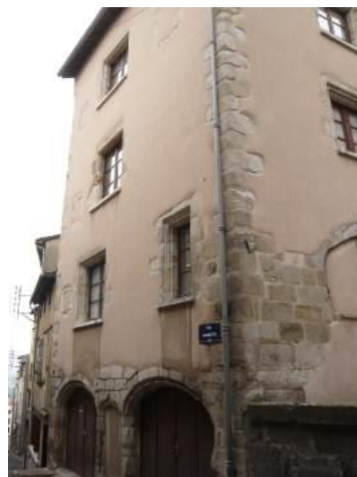
1, rue Gambetta. Appareil en assises réglées en blocs de granit et d'arkose.
