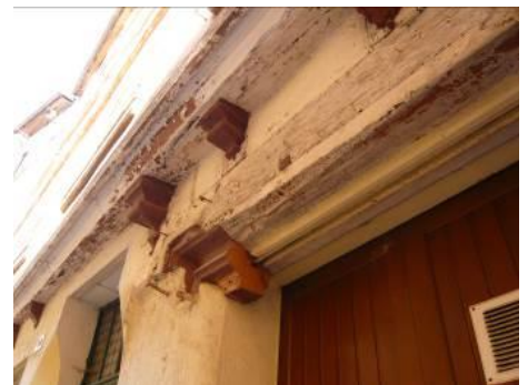
26, rue de la Coutellerie. La sablière de la devanture est profilée de moulures.
