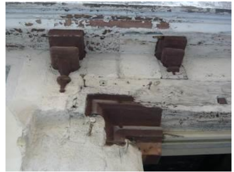
26, rue de la Coutellerie. Abouts de solives moulurés en culots prismatiques
