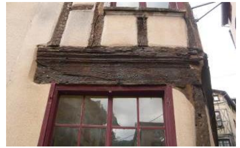
51 rue de la Coutellerie. Un écoinçon et l'arc en accolade taillé dans la sablière situent l'ouverture de l'ancienne devanture.
