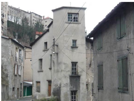
Rue Montmillant. Escalier en vis demi-hors-œuvre
