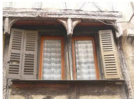
10, rue du Marché. Les vestiges d'un appui en bois, à gauche, signale l'emplacement de la fenêtre à meneau d'origine.
