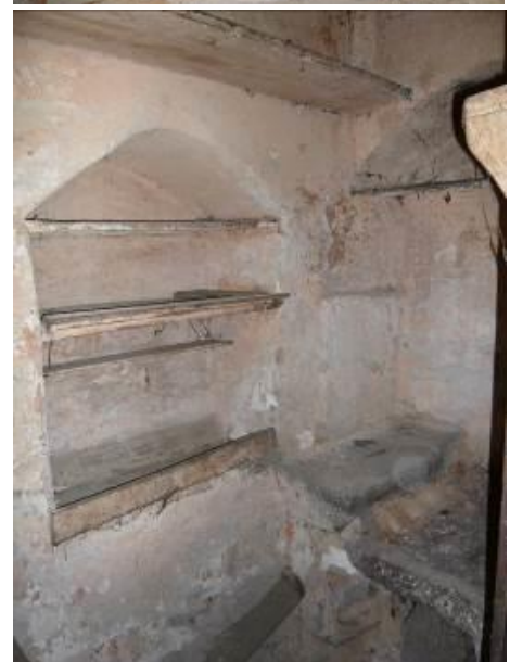
11 rue du Bourg. La souillarde avec ses étagères et sa niche d'évier forme une loge dans la cuisine.
