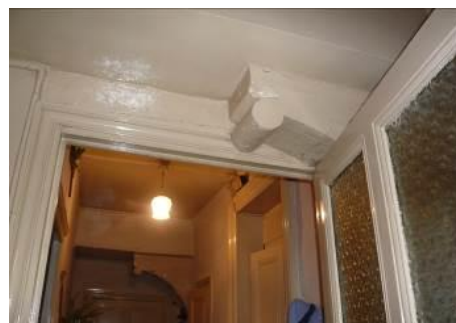
3, rue de Lorraine. La console du plafond s'orne d'un large tore.
