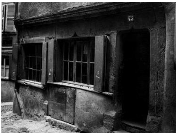
45, rue de la Coutellerie. Les traces d'assemblage témoignent de l'emplacement de l'égal sur les poteaux de la devanture photographiée en 1947 (Cl. Médiathèque du Patrimoine)
