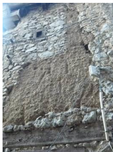
7, rue de Lorraine. Façade en maçonnerie remaillée en sous-œuvre en terre crue (pisé).
