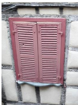
5, rue du Pirou (217-2). Appui chantourné habillé d'une protection en zinc.
