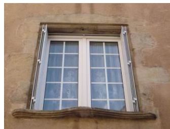
20, rue Alexandre Dumas (260-2). La fenêtre du XVIe siècle a été remaniée au XVIIIe siècle : ajout d'une feuillure sur le tableau et d'un appui chantourné.
