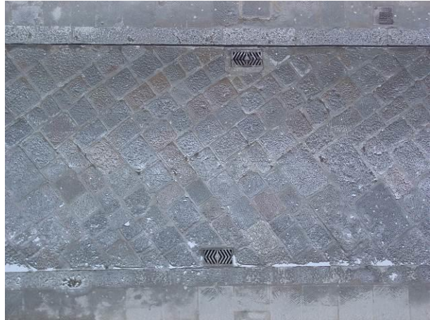
Dalles posées en arêtes de poisson (Arezzo)
