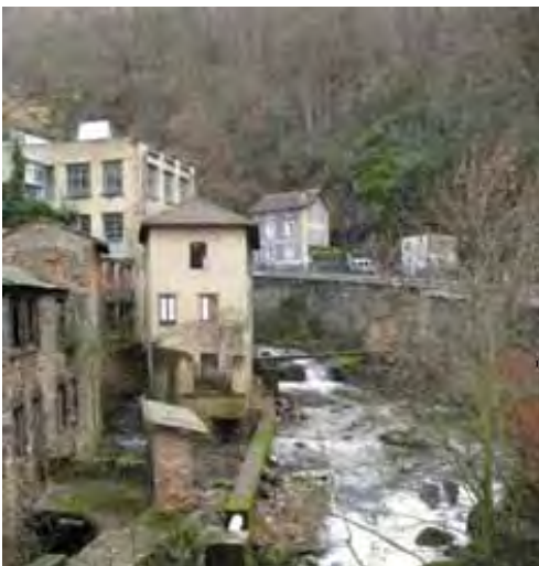
Photo 8 : secteur de gorge (source BCEOM)
